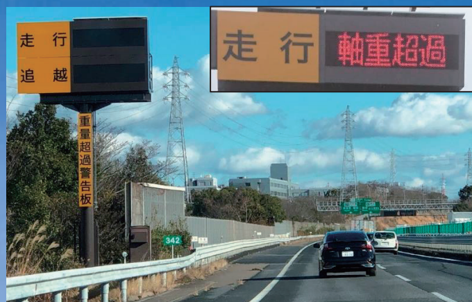
高速道路本線での「軸重超過」表示
