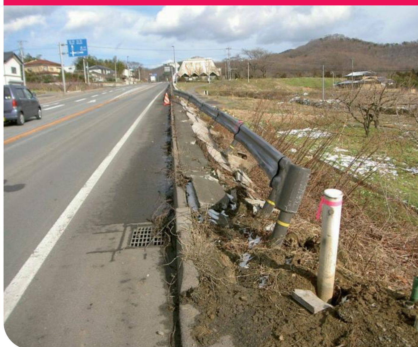
ガードレール・標識等の損傷
